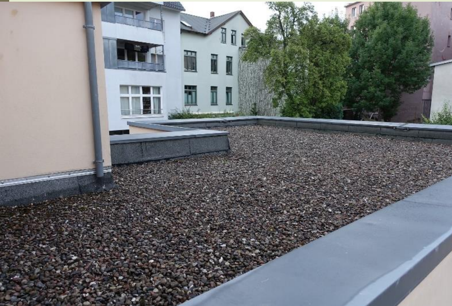
„Totes Kiesdach“, Juli 2021
