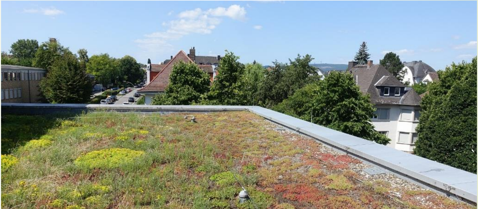
Extensive Dachbegrünung, Technische Hochschule Mittelhessen 23.6.2021
